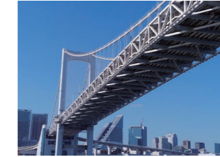
レインボーブリッジ 採用塗料(改修時)：デュフロン100ファイ ンHB(厚膜形フッ素樹脂塗料)
