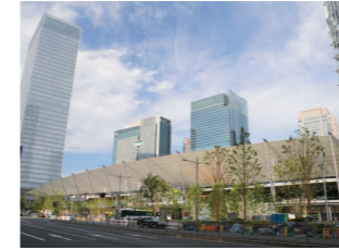
東京駅八重洲グランルーフ 採用塗料：タイカリット(耐火塗料)+デュフロ ロン4F2 スーパーフレッシュ(4フッ化フッ 素樹脂塗料)
